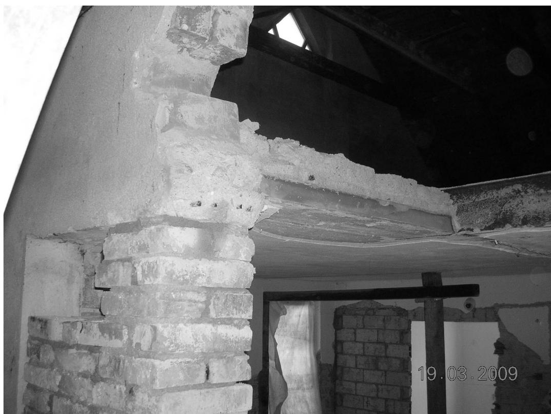
Obrázek 2 – fotodokumentace z 03/2009 – skladba stropu nad 1.NP
