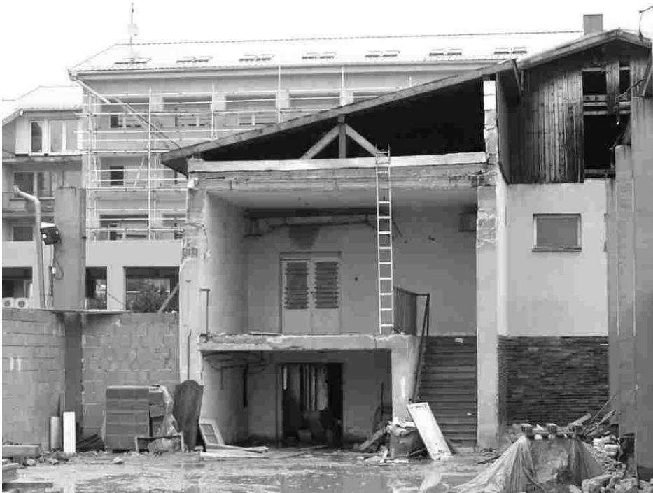
Obrázek 1 - Fotografie stavebních úprav objektu.
