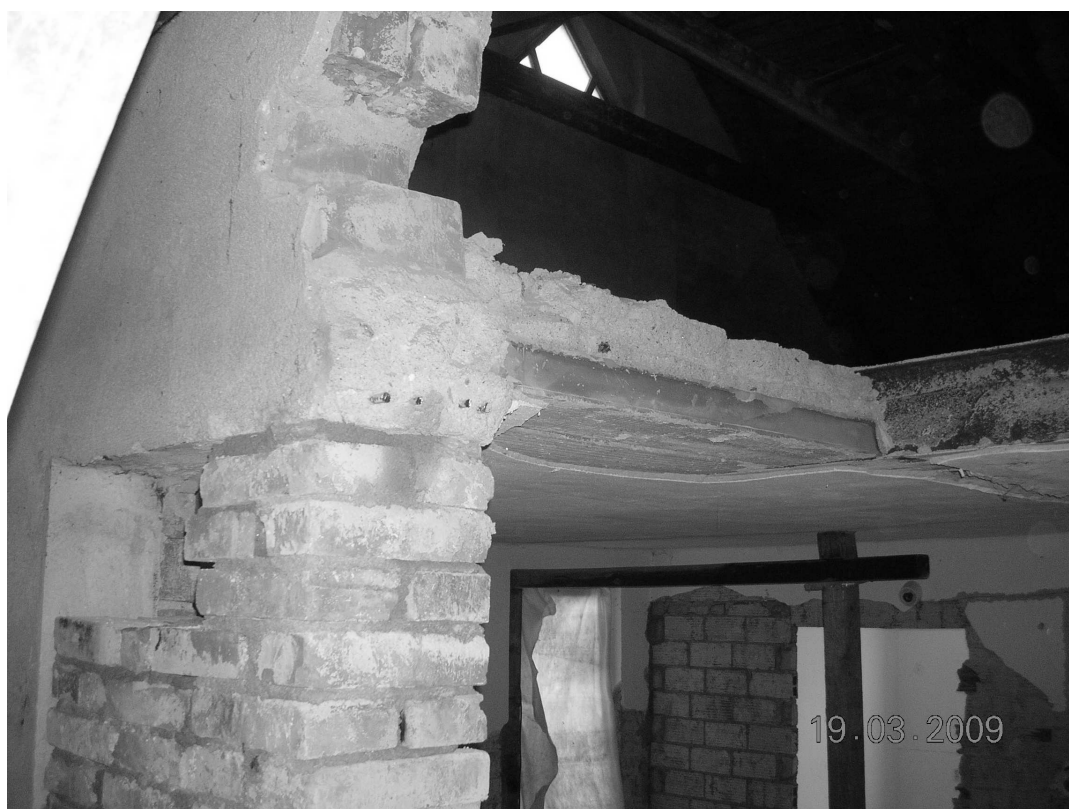
Obrázek 2 – fotodokumentace z 03/2009 – skladba stropu nad 1.NP
